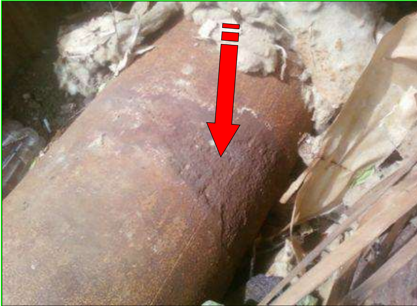
Фото 3. Фактическое состояние трубопровода по выявлению диагностики
